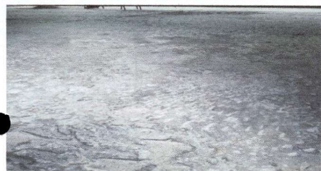
Foto 5: Sustrucción de piso torta de concreto por piso ceramico en aulas
