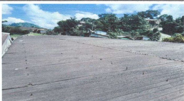
Foto 1: Sustrucción de lámina, por lámina, troquelada aluzinc calibre 26 (aulas, direccion, cocina, bodega, comedor y baño)
