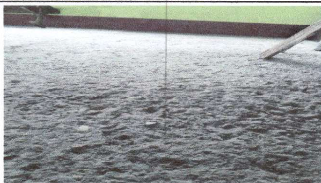
Foto 2: Sustrucción de piso de torta de concreto por piso cerámico (3 aulas y corredor)
