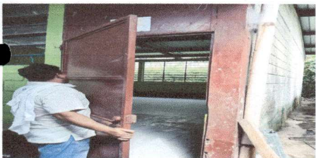
Foto 3: Sustrucción de puertas de metal, por puerta de metal (5 puertas de metal)
